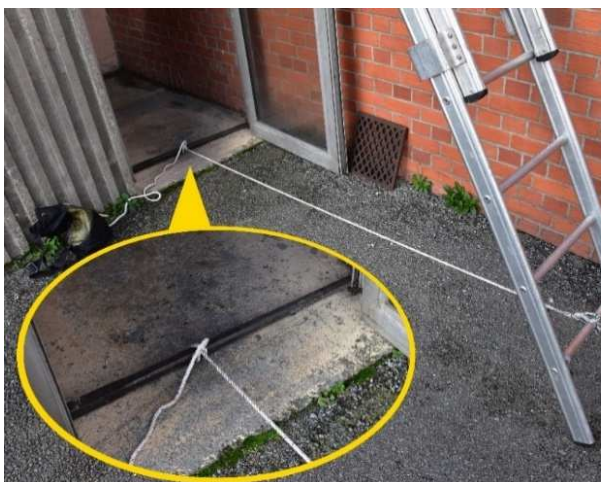
Contre un élément de maçonnerie.
